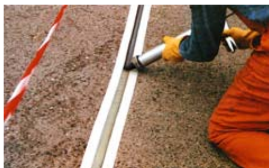
Elastické utěsnění pojížděné dilatační spáry na betonové vozovce hmotou PCI Escutan TF.
