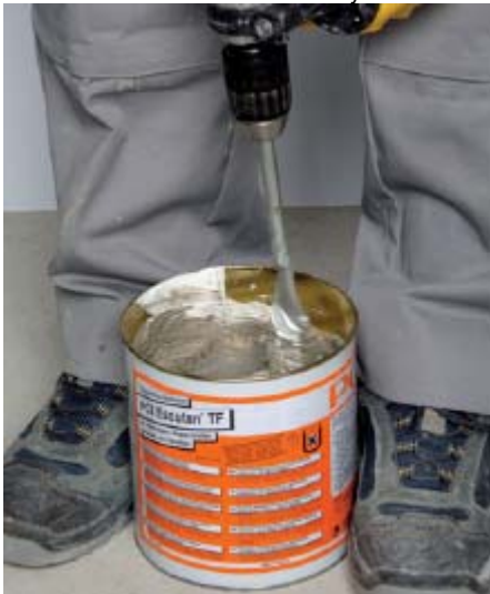
Rozmíchání tvrdidla a základní složky
