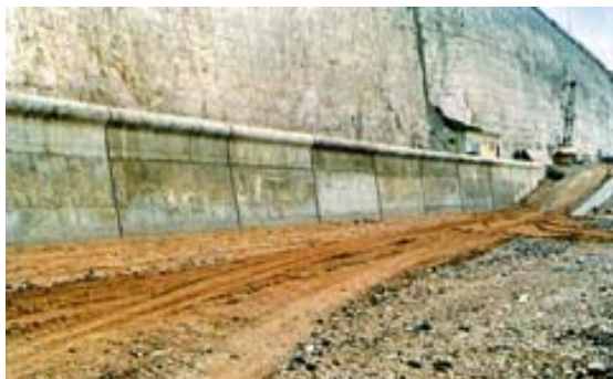
Hmota PCI Escutan TF k utěsnění spár v protizáplavové zdi.
