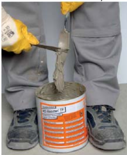
Očištění míchadla po rozmíchání.
