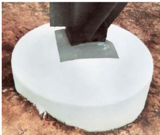
Elastická izolace hmotou PCI Escutan TF zabráňuje vodě proniknout do betonového základu rohové podpěry stožáru vysokého napětí.
