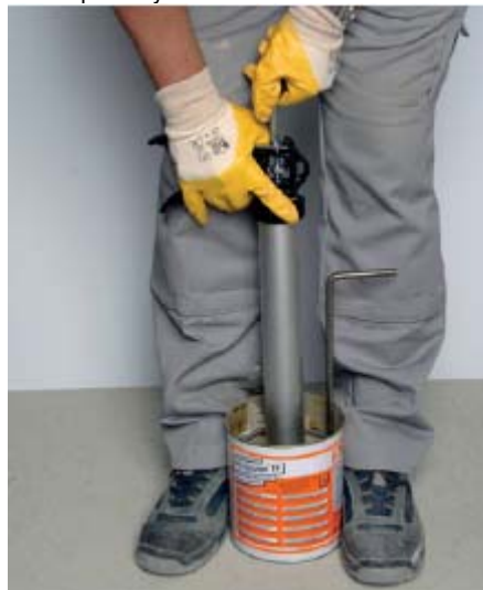
Plnění prázdné tlakové pistole hmotou PCI Escutan TF
