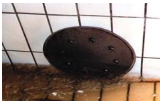
Trvalé těsnění trubního otvoru hmotou PCI Escutan TF.
